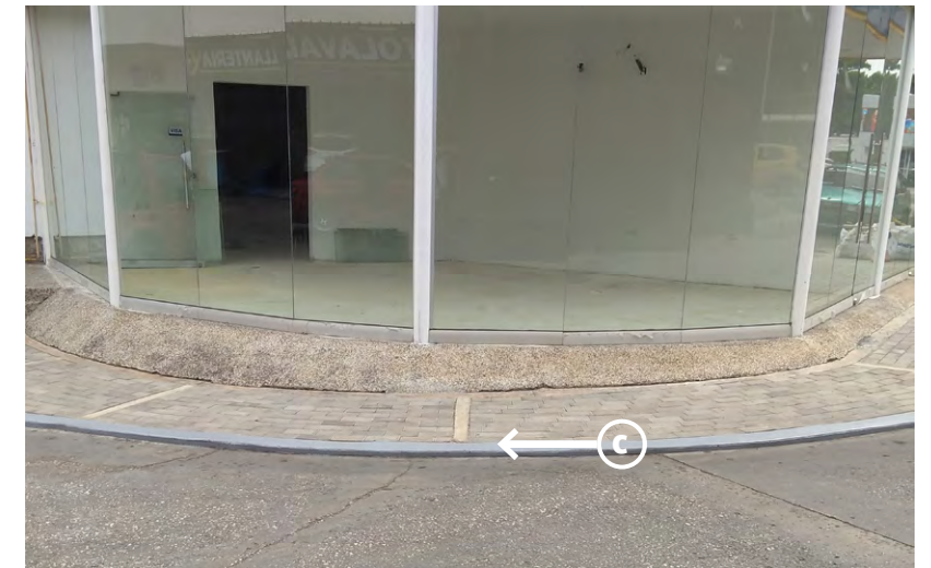
c → Borde andén: Espacio peatonal dentro de las estaciones que direccionan a los locales comerciales - Color Gris medio Petromil
