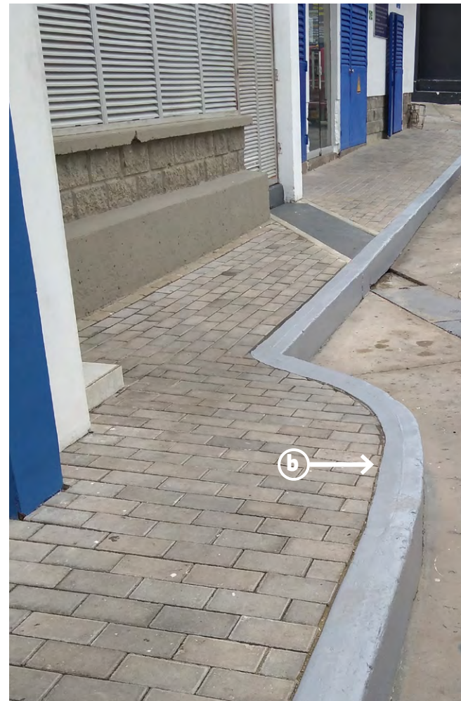
b → Borde andén: Espacio peatonal dentro de las estaciones que direccionan a los locales comerciales - Color Gris medio Petromil
